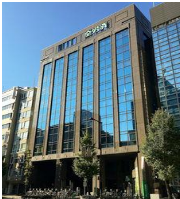
モルティ天神ビル外観
